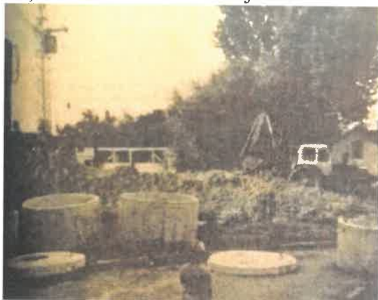
1.attēls: Zemgale, 1991.gada 1.augustā, Sadzīves kanalizācijas vada izbūve
