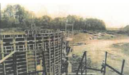
Attēls: Pirmajam “tankam” pabeigta betonēšana (Zemgale, 2000.gada 14.oktobris)
